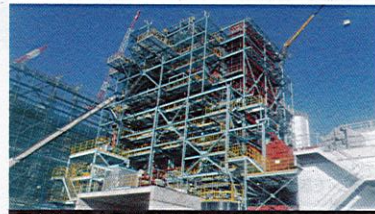
国内外での大型プラント工事に対応する
